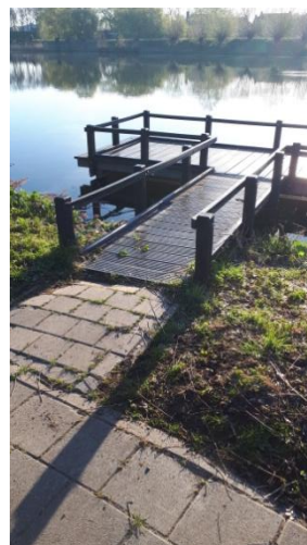
overgang naar vissteiger goed aan laten sluiten op nieuwe verharding
