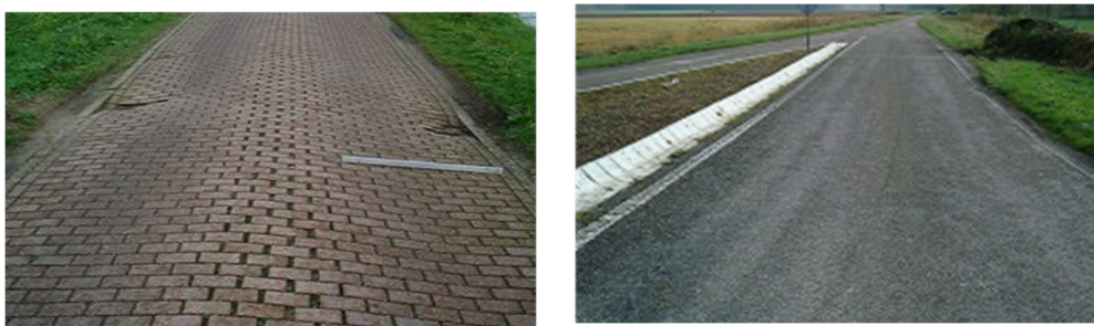
Figuur B2-2 Schades dwarsonvlakheid en rafeling E.
